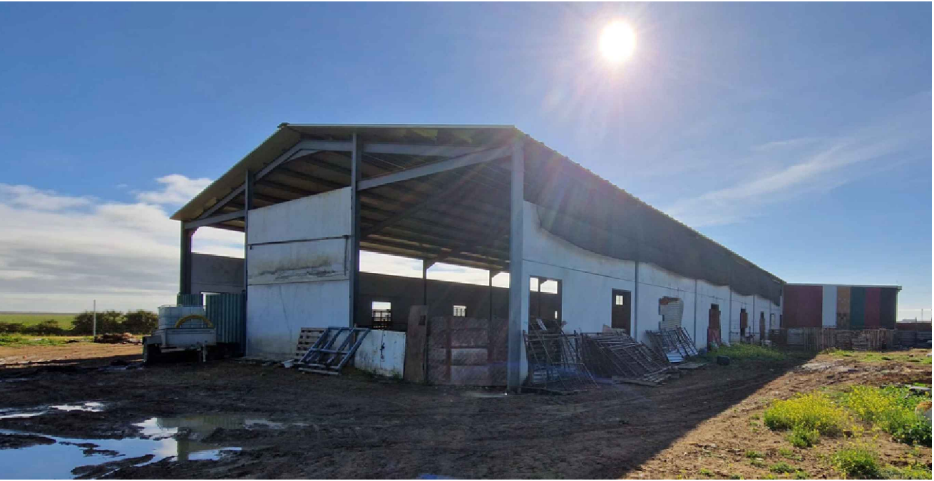
FACHADA TRASERA-LATERAL IZQ.
